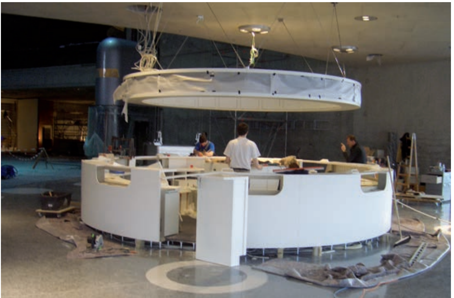
Ticketkasse mit abgehängtem Infoelement in der Bauphase
